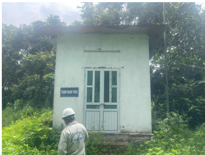
Hình 26. Khu trạm quan trắc nước thải tự động, liên tục
