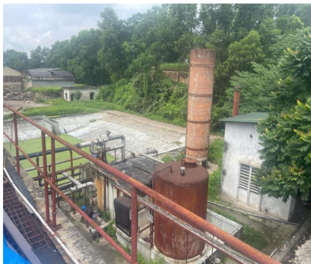
Hình 27. Vị trí đốt khí Biogas thừa
